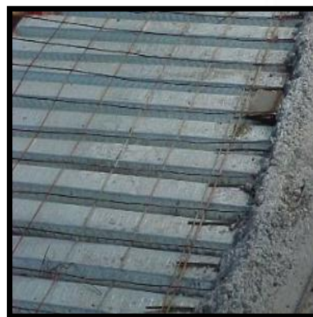
7. Se coloca el refuerzo por temperatura (electromalla)
