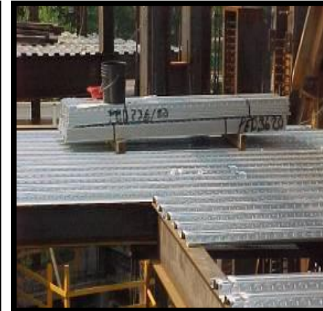
4. Se colocan las molduras perimetrales.
